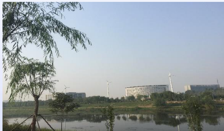
北京风电储能系统
