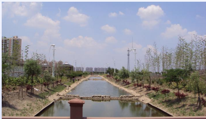
上海风力储能系统
